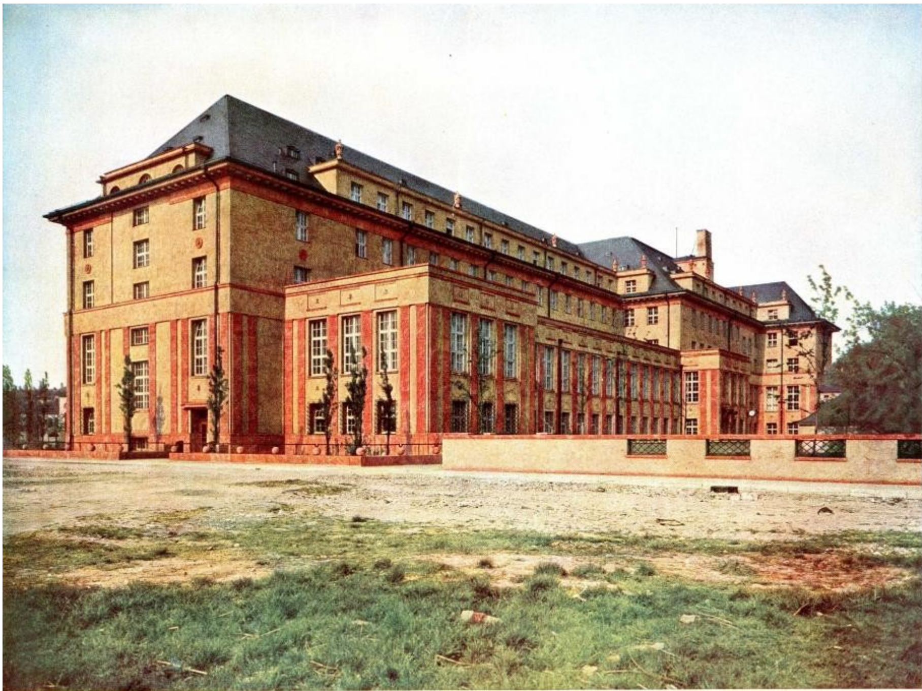
Verwaltungsgebäude Allgemeine Ortskrankenkasse für die Stadt Leipzig in Leipzig (Hofansicht), erb. 1923/25
